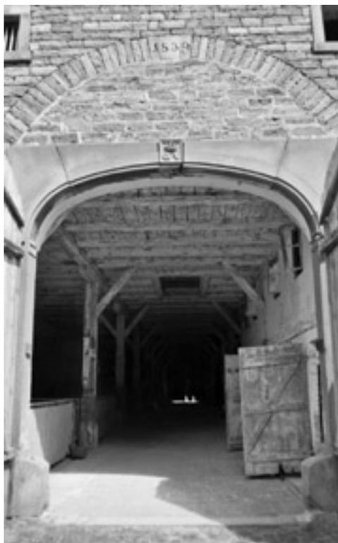
Abb. 4: Tor des jüngeren Schafstalles von 1839: Werksteingewände mit Königskrone und Initialien E(rnst) A(ugust) und Datierung auf dem Schlussstein des Entlastungsbogens darüber – und damit nebenbei ein frühes Beispiel für „materialgerechtes“, bewusst unverputzt gelassenes Sichtmauerwerk.
